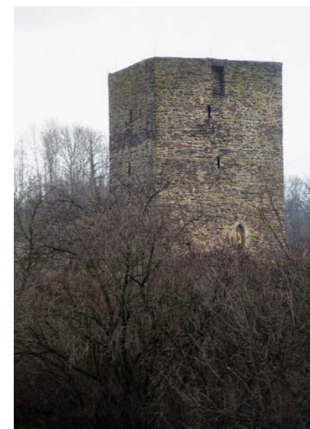
Pohled na turz z návrší u semtěšského hřbitova, jihozápadní stěna
