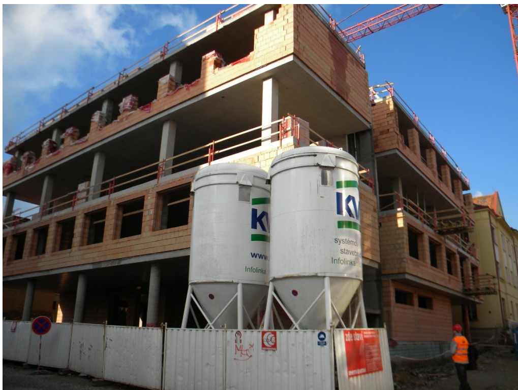
Stavba nové budovy městského úřadu
