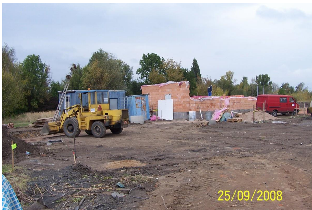
výstavba autobusového nádraží 25. 9. 2008
