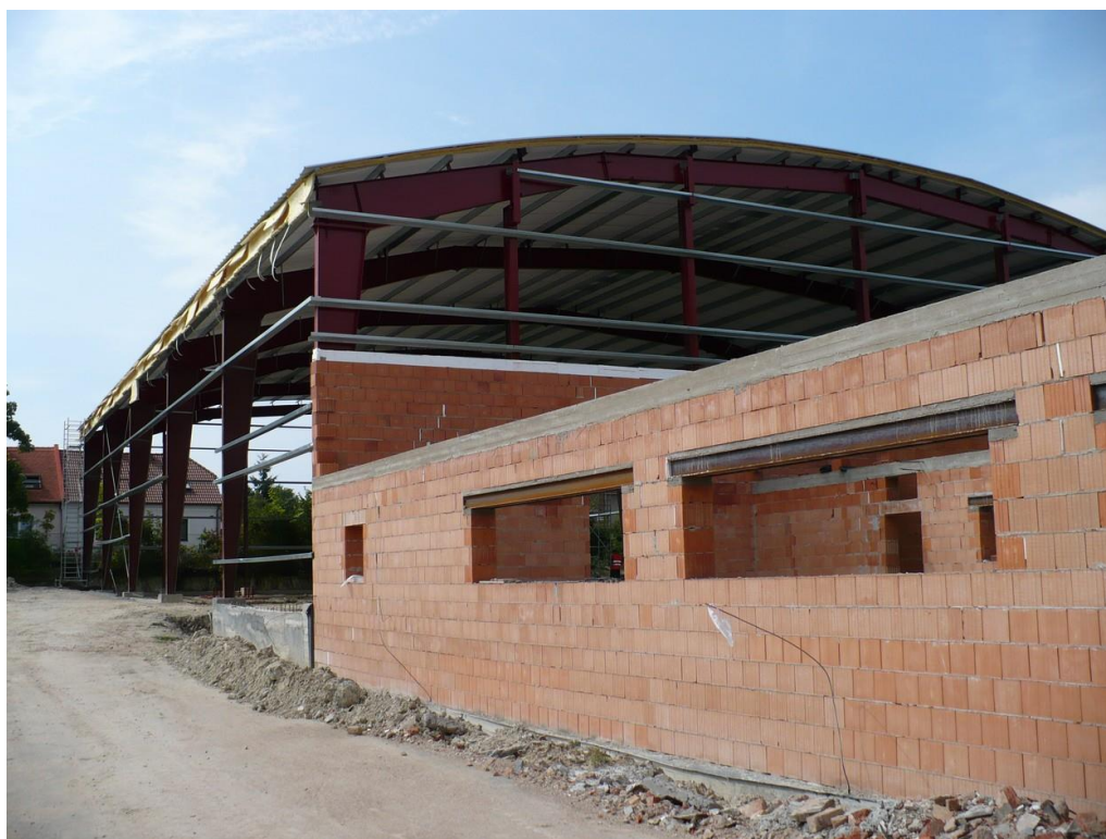
výstavba sportovní haly 22. 8. 2008
