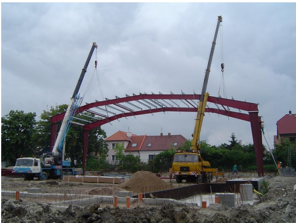
stavba konstrukce nové sportovní haly 17. 7. 2008
