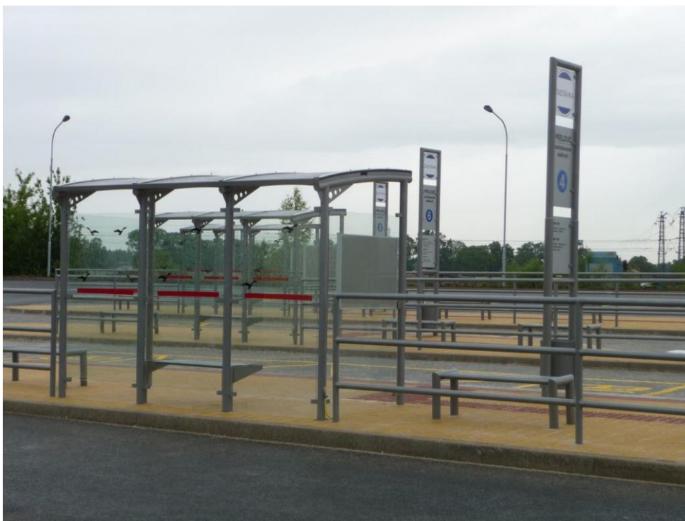
Nástupiště nového autobusového nádraží 11. 6. 2009
