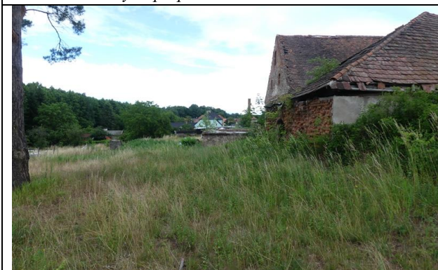
Charakter porostů při stěnách objektů v oblasti D (v popředí vpravo, zde jen instalace ležení pro sanaci stěn)
